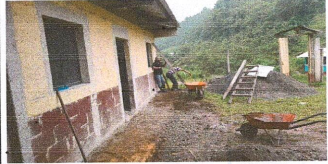
Foto 4: preparación de espacio para la fundición de 23 ml de banqueta.
