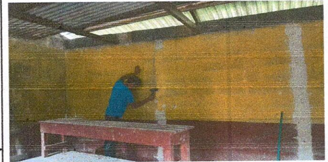
Foto 7: preparación de área, para la aplicación de repello gris para nivelar los muros de la cocina y bodega.
