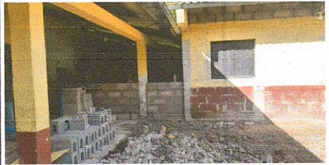
Foto 2: Levantado de paredes frontales para unificar ambientes de aula y cocina, espacio destinado para bodega.
